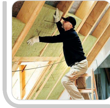
Zwischensparrendämmung
