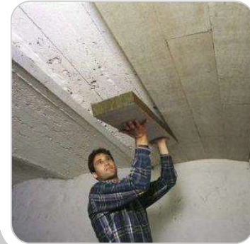
Dämmung von Gewölbekappen
