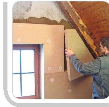
Außenwanddämmung von innen
